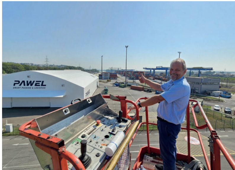
Ing. Mag. Michael Pawel zeigt hier stolz auf die neue Halle in Leichtbauweise neben dem Terminal in Ennshafen
